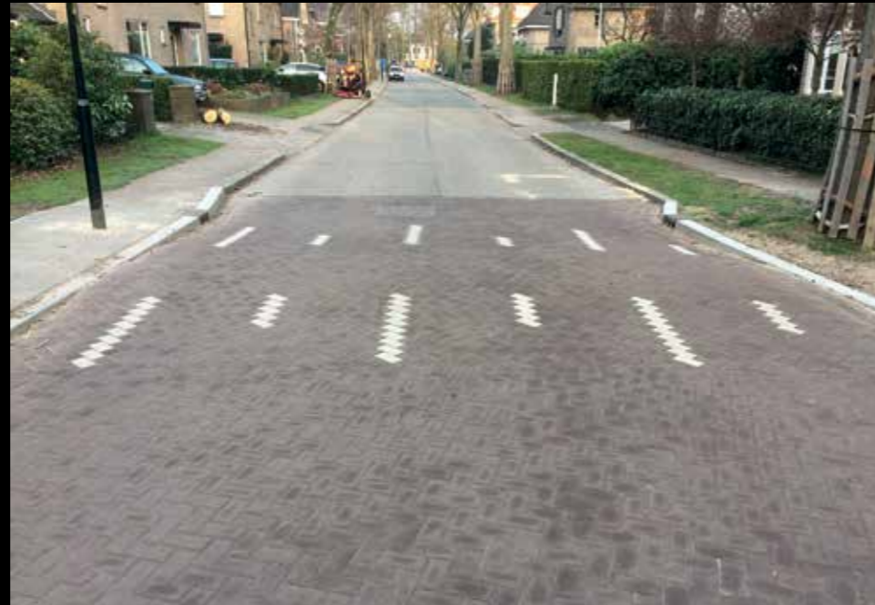
In project De Parken worden de markeringsstrepen voor drempels meegelegd in het straatverband.
